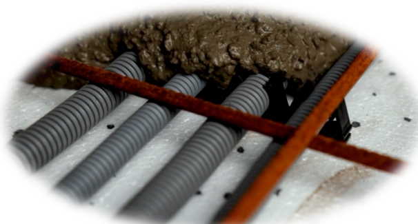
Installationsexempel i gjutet golv
